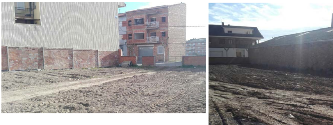
Figura 7. Imatges de les parets laterals a gestionar
